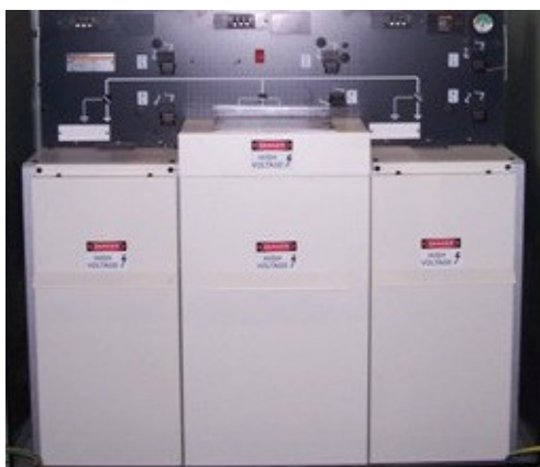
Schneider RM6 Switchgear
